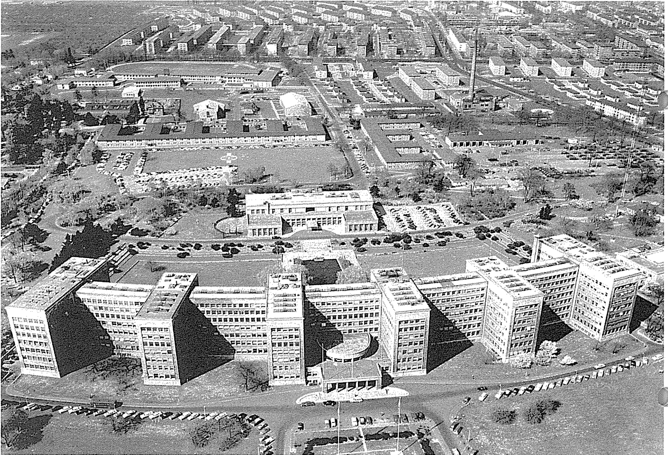
Das IG-FARBEN-Hauptgebäude in Frankfurt/Main
