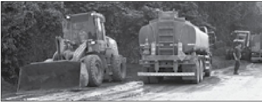
Eine Trasse durch den Regenwald: Bau der Bundesstraße BR-163
