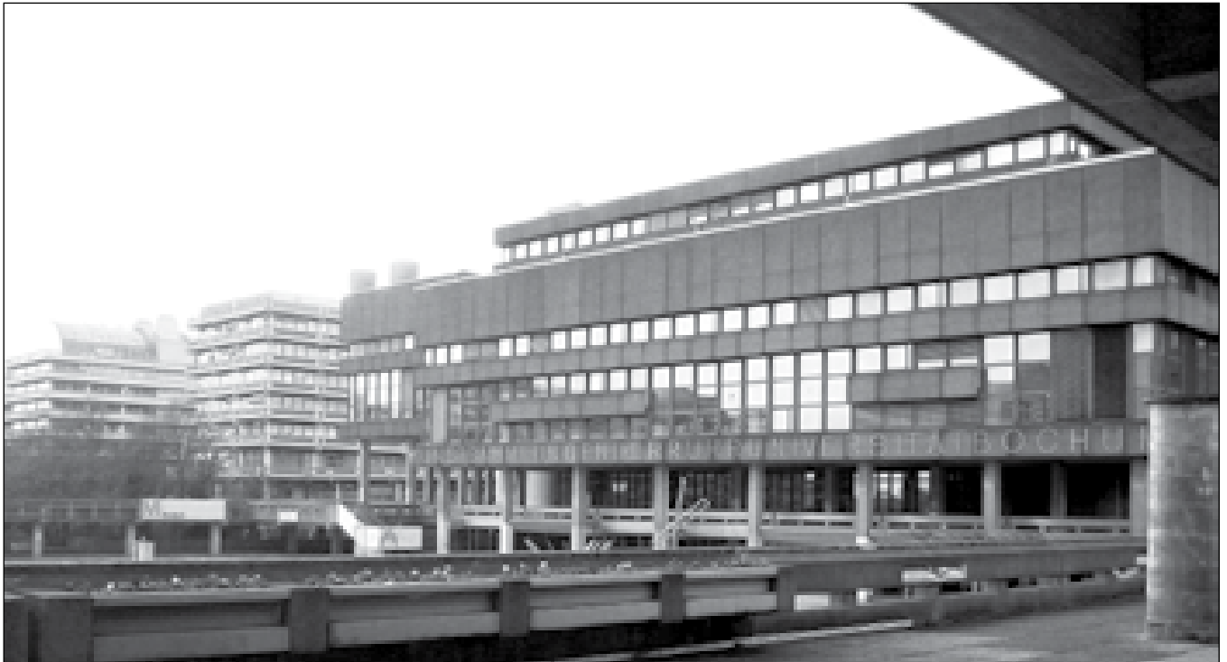
PCB-Sanierungsfall Ruhr-Universität Bochum
