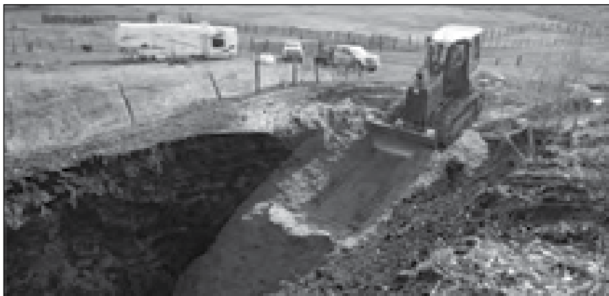
Sanierungsarbeiten an der stillgelegten Ballard-Mine
