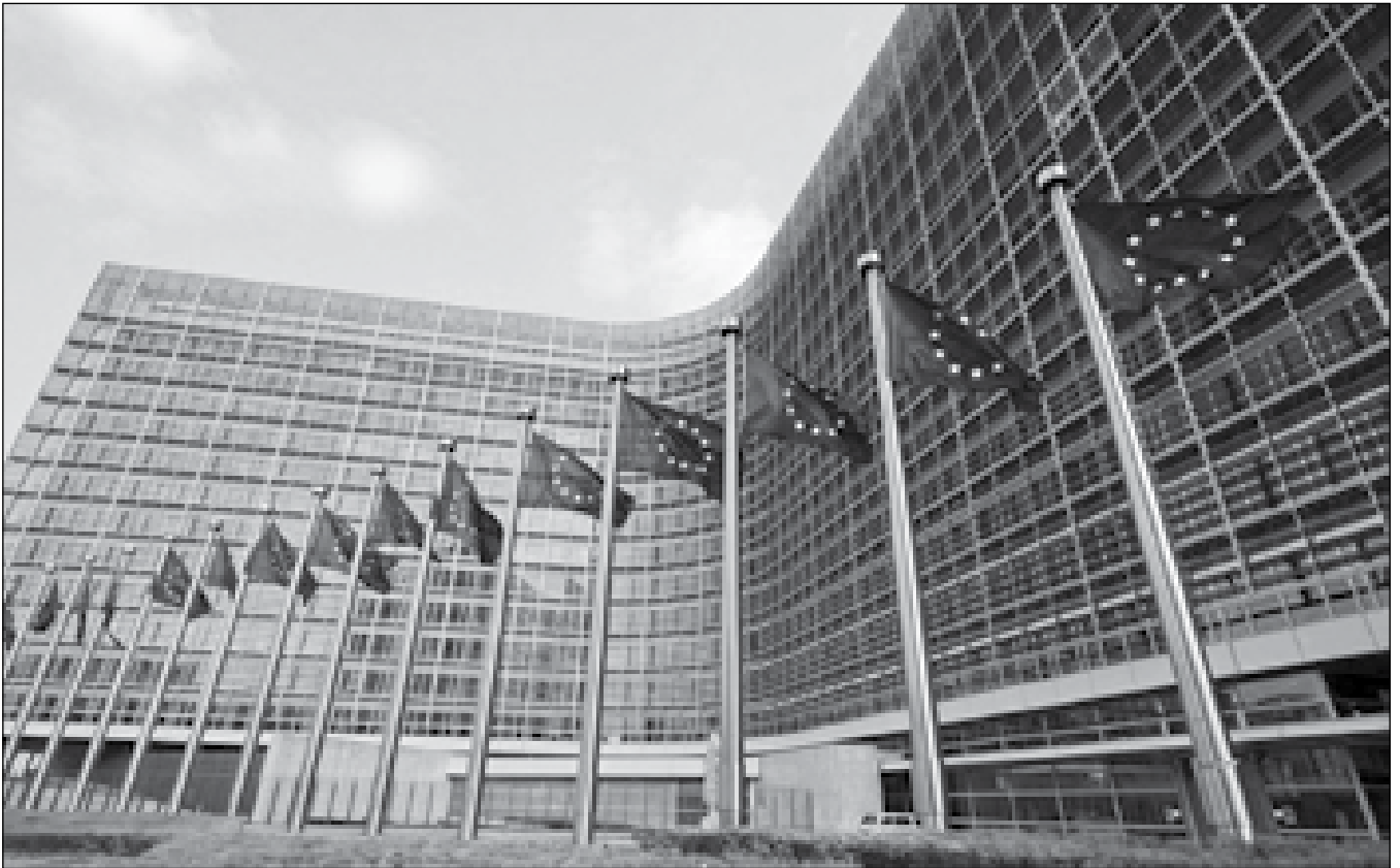
Das Gebäude der EU-Kommission in Brüssel
