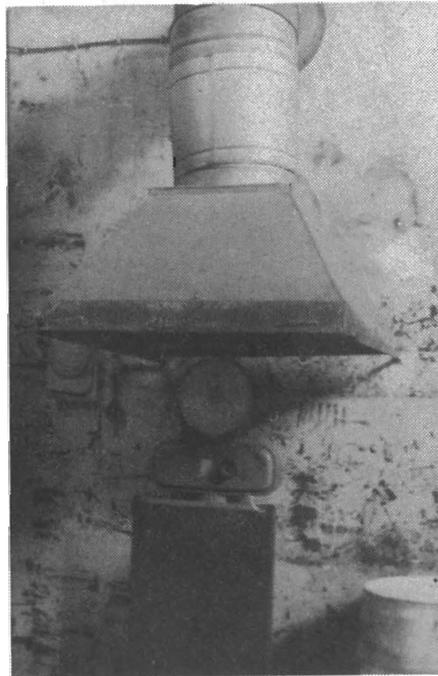
Wir erkennen darauf eine Waage, die zum Abfüllen gefährlicher Stoffe benutzt wird. Darüber eine Absaughaube.
